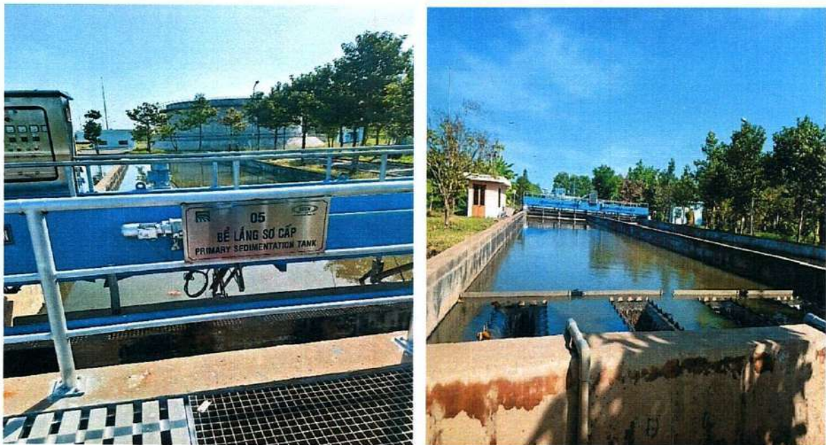
Hình 1. Hệ thống xử lý nước thải Nhà máy xử lý nước thải sinh hoạt thành phố Sóc Trăng
